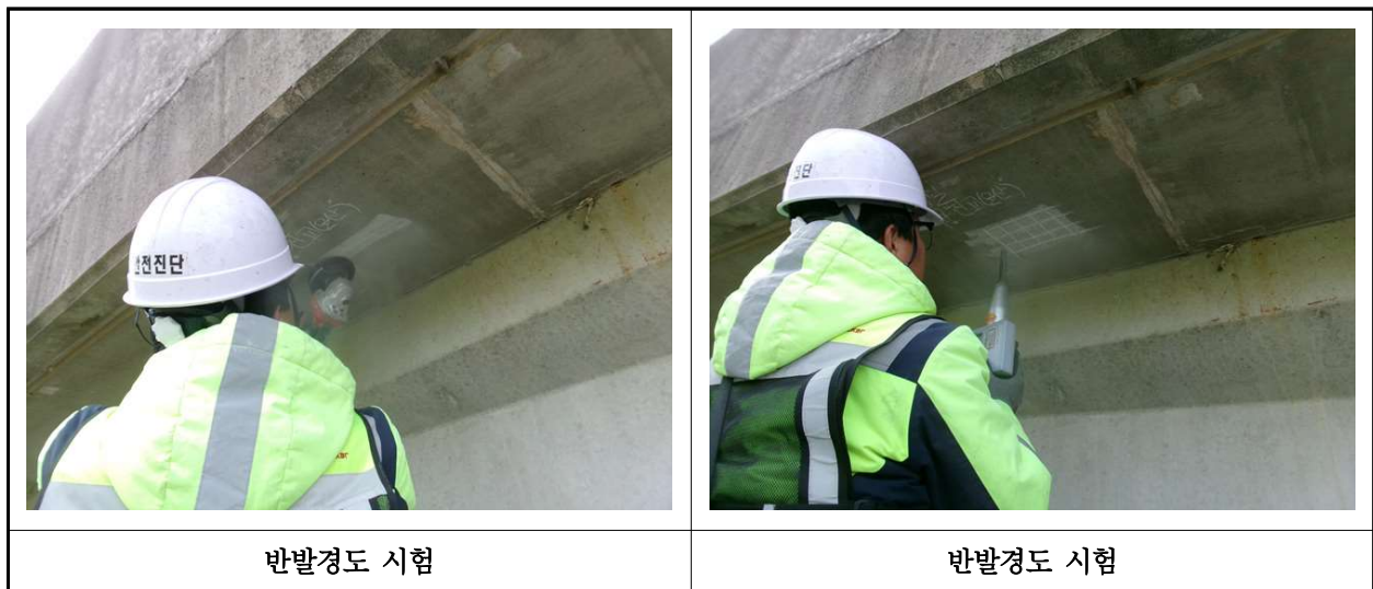
【사진 16.4.2】 반발경도시험 현장사진
