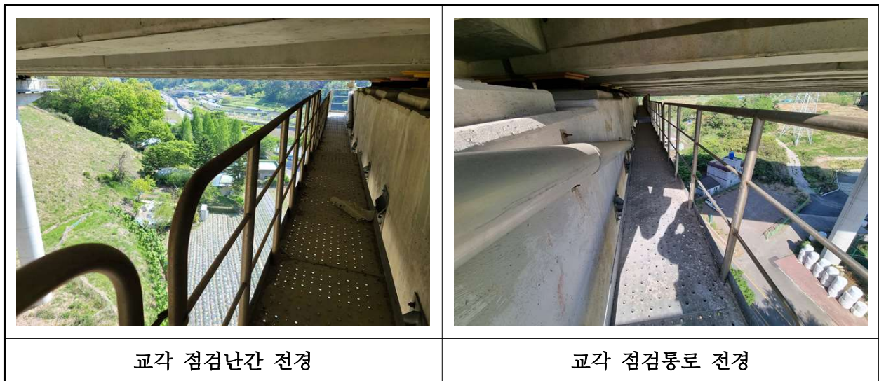
【사진 16.3.26】 교량 점검시설 전경
