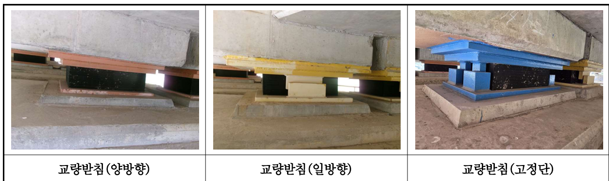
【사진 16.3.13】 교량받침 전경
