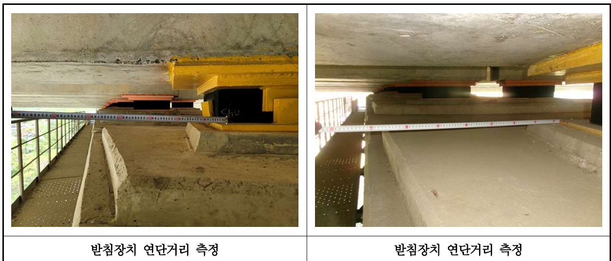
【사진 16.3.15】 교량받침장치 연단거리측정
