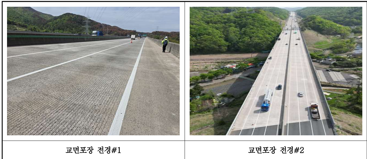
【사진 16.3.20】 교면포장 전경
