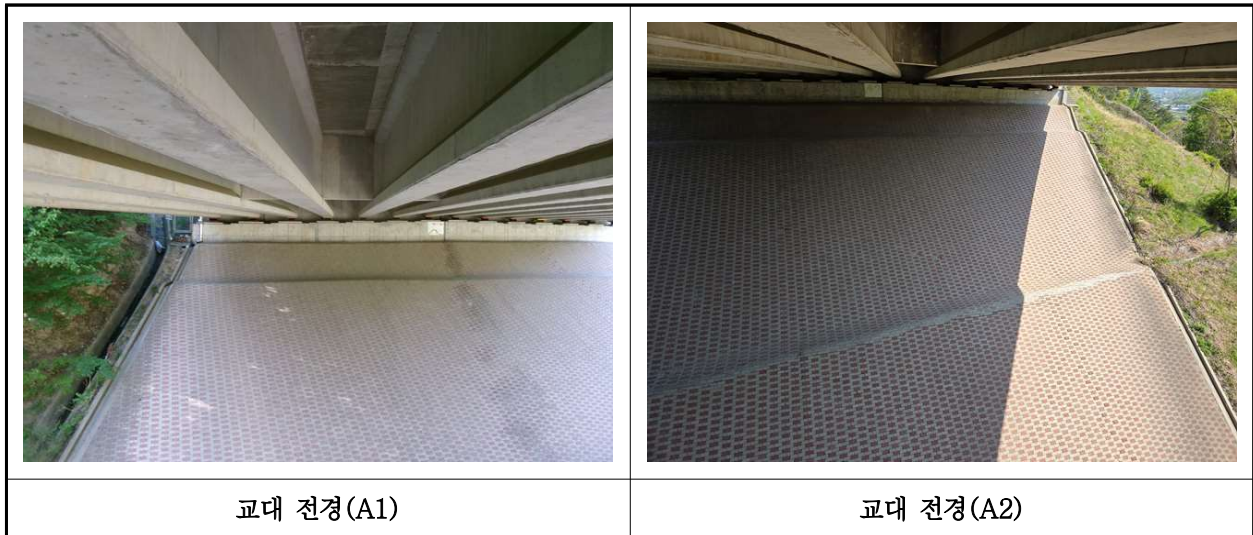
【사진 16.3.8】 교대 전경
